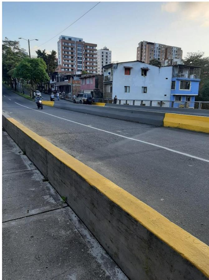
**Fotografía 3. Pintura de los muros New Jersey**
