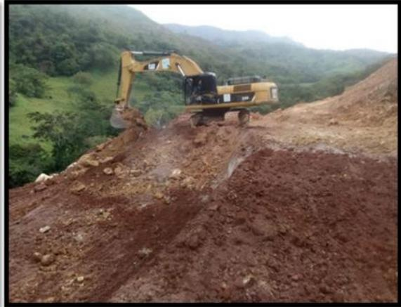
Fotografías 12 - 13. Se realiza el inicio de movimiento del material tipo coluvión.
