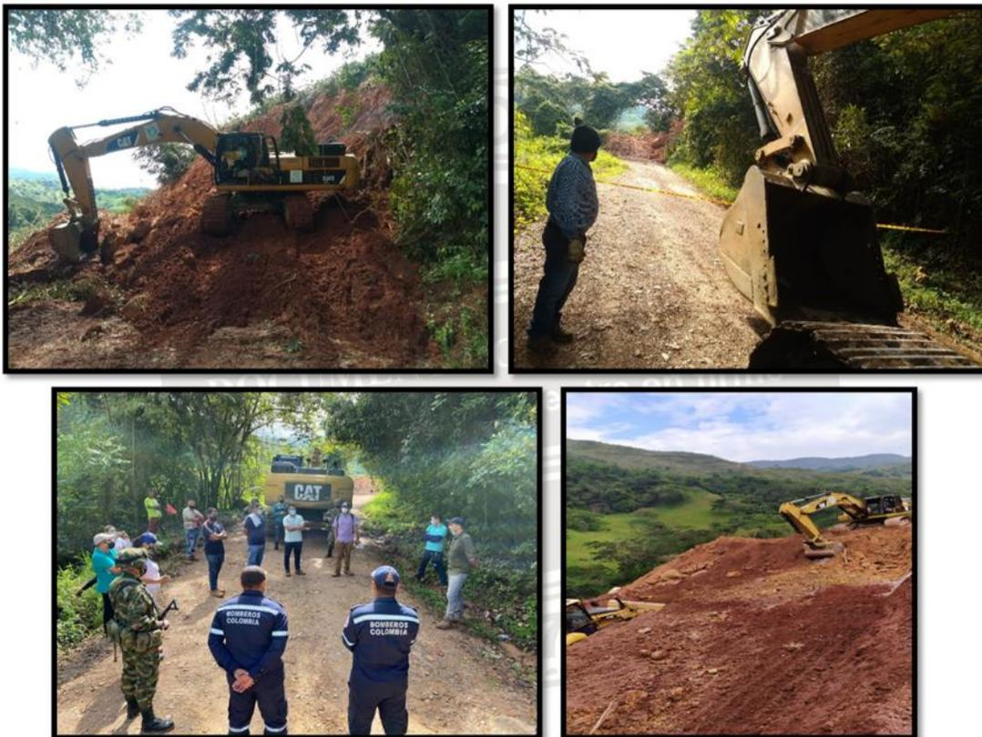
Fotografías 8 - 11. Se realiza el inicio de movimiento del material tipo coluvión.
