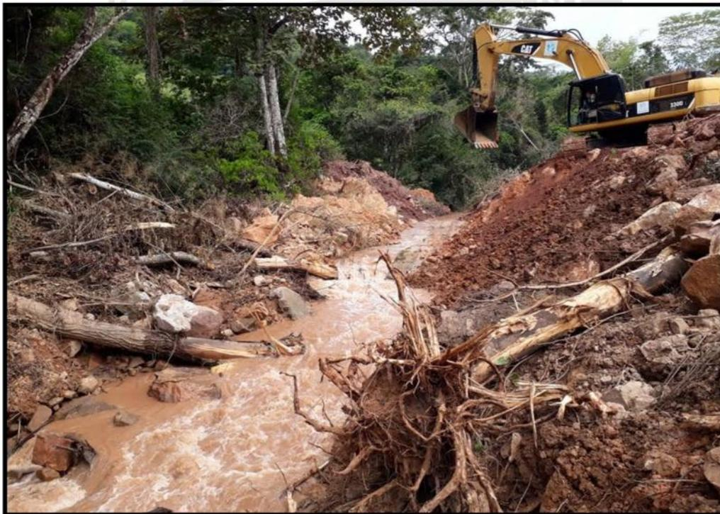
Fotografía 19. Trabajos de remoción del material de la quebrada Ata.
