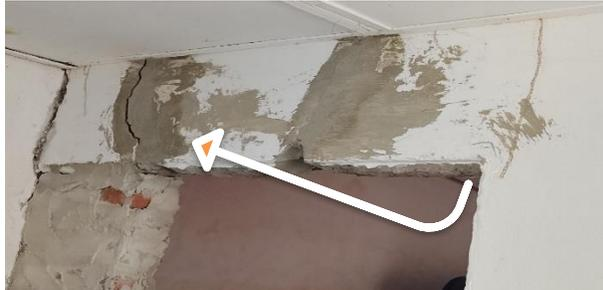
la presencia de fisuras, grietas severas en los muros, de sala, alcobas y baño, se dan como daño severo (grietas exceden los 6mm, (debido a los asentamientos diferenciales que ha sufrido la vivienda, está posee unas grietas profunda en la zona de la sala, horizontal, alcobas en forma vertical y diagonales como evidencian las fotos), se evidencia desprendimiento de muros en alguna áreas.
