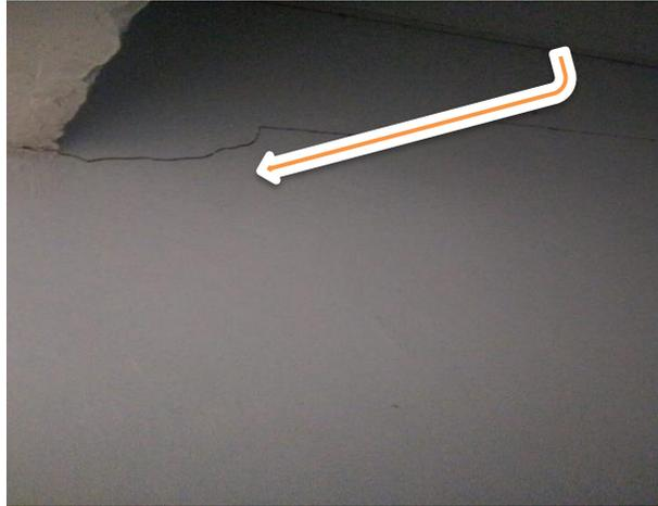
En las imágenes se evidencia grietas con muros colapsado, muy severa en alcobas, va desde arriba hacia abajo pasando por viga.
