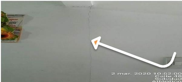
la presencia de fisuras, grietas severas en los muros, de sala, alcobas y baño, se dan como daño severo (grietas exceden los 6mm, (debido a los asentamientos diferenciales que ha sufrido la vivienda, está posee unas grietas profunda en la zona de la sala, horizontal, alcobas en forma vertical y diagonales como evidencian las fotos), se evidencia desprendimiento de muros en alguna áreas.
