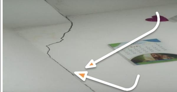
muros con grietas verticales severas con mas de 6mm
