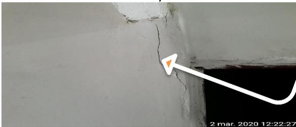
la presencia de fisuras, grietas severas en los los muros, de sala, alcobas y baño, se dan como daño severo (grietas exceden los 6mm, (debido a los asentamientos diferenciales que ha sufrido la vivienda, está posee unas grietas profunda en la zona de la sala, horizontal, vertical y diagonales como evidencian las fotos), se evidencia desprendimiento de muros en alguna áreas.
