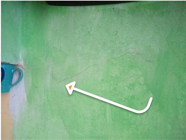
Muro sala con presencia de fisura en forma diagonal.
