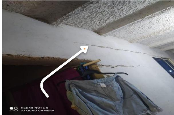
Grietas severas en muros sala y humedad en alcoba
