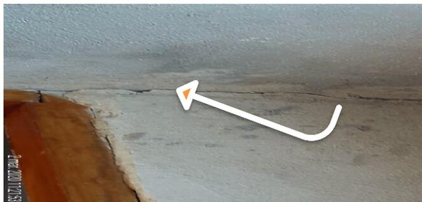
Se evidencia desprendimiento de muro divisorio, desgaste del mortero.
