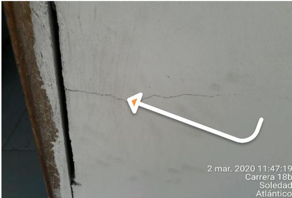
Muro sala con presencia de fisura en forma horizontal.
