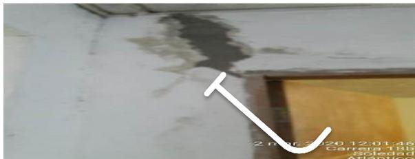
la presencia de fisuras, grietas severas en los los muros, de sala, alcobas y baño, se dan como daño severo ( grietas exceden los 6mm, (debido a los asentamientos diferenciales que ha sufrido la vivienda, está posee unas grietas profunda en la zona de la sala, alcobas, cocina, grietas en forma horizontal, vertical y diagonales como evidencian las fotos), se evidencia desprendimiento de muros en alguna áreas.
