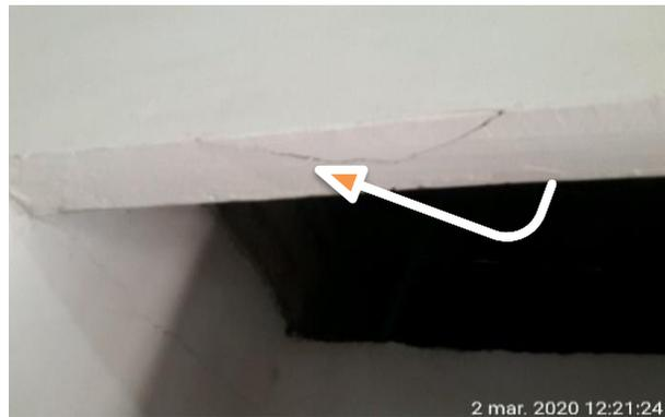
Muro colapsado casi con volcamiento entre sala y alcoba
