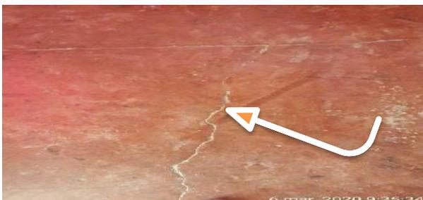
Pisos agrietados en toda la vivienda, se evidencia asentamiento severo, en pisos y andenes
