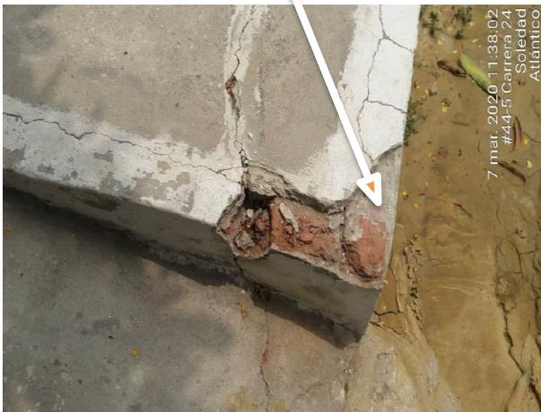
Muros con grietas en alcoba y andenes con hundimiento
