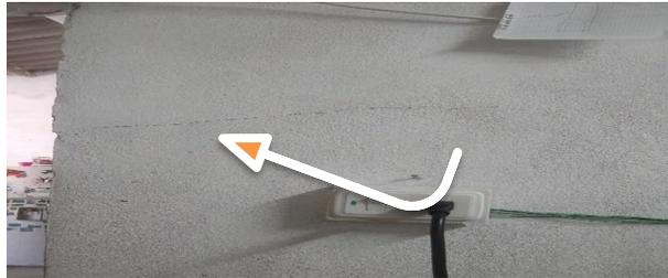
Muro con grieta horizontal sala y alcoba
