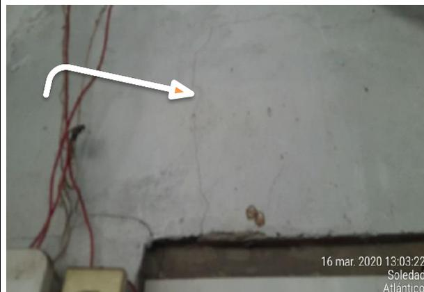
Muros con fisuras leves en sala
