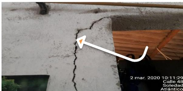
Se evidencia desprendimiento de muro divisorio, desgaste del mortero.
