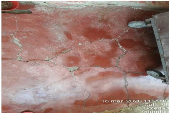
debemos agregar a la causa de la grietas una carga puntual que está recibiendo el vano de la puerta en la zona superior, y al no poseer un dintel construido con las especificaciones correspondientes, se crea la grieta con mayor facilidad.
