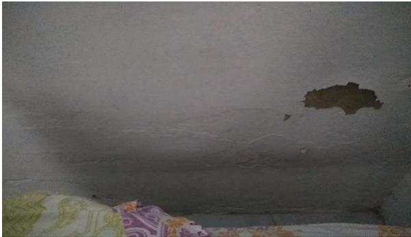
Presencia de grietas en forma horizontal, vertical y en diagonal en sala, patio y alcobas.
