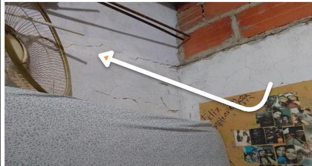
Grietas severas en muros alcoba, desprendimiento
