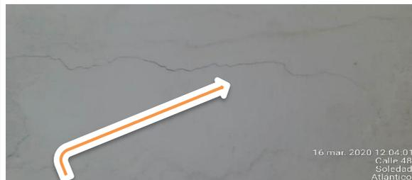
Grieta horizontal, fractura severa, en muro sala
