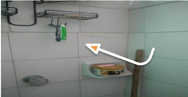
Presencia de grietas en forma vertical entre dos muros.
