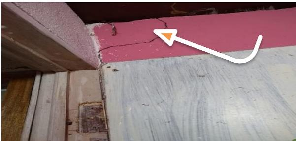
Muro divisorio alcoba a sala con desprendimiento y piso en tablón con grietas severas
