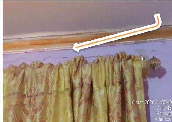
En las imágenes se evidencia grietas con muros colapsado, muy severa en alcobas, va desde arriba hacia abajo pasando por viga, y en forma horizontal.
