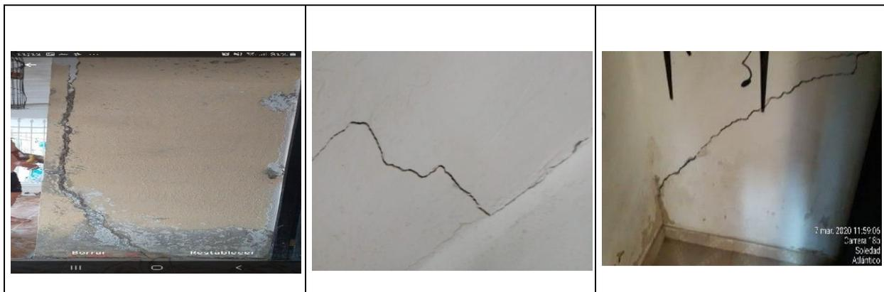
Otra causa puede ser sencillamente una cimentación incorrecta, mal proyectada, con cimentación corrida en base a plantilla de concreto sin los requisitos indispensables según la
