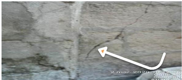
En las imágenes se evidencia el estado de la vivienda con mucha presencia de grietas severas, en alcobas, sala, pisos, también se evidencia el desgaste del mortero pañete, con el pasar del tiempo, todo debido al asentamiento que está teniendo el terreno y en parte por la cimentación corrida que se les hizo, que no contaban con las especificaciones técnicas adecuadas.
