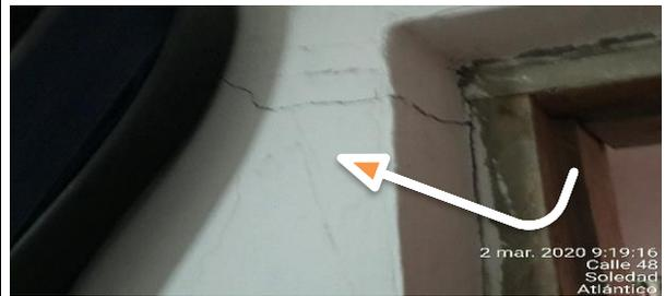
Muro colapsado con grieta profunda
