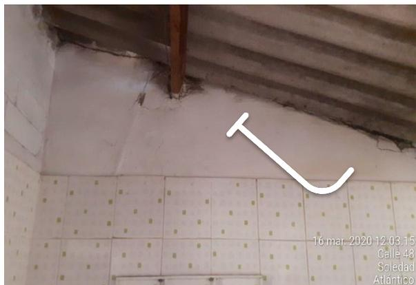
Se evidencia la falta de viga perimetral, y desprendimiento de muro.
