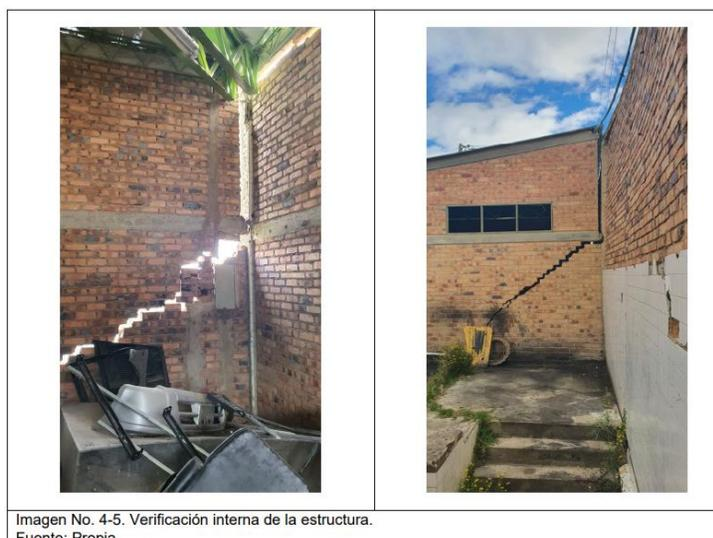
De igual forma al realizar la verificación interna de la estructura se evidencia la continuidad de la falla mencionada anteriormente como se aprecia en la imagen No. 5 donde se refleja un desprendimiento **por volcamiento lateral de toda la estructura** generando una inclinación hacia el talud existente contiguo a la vía.
