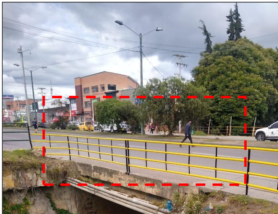
Fotografía 2. (se evidencia instalación de baranda costado ingreso barro los rosales.)
