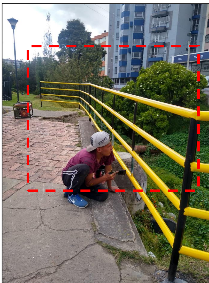
Fotografía 1. (Instalación baranda costado clínica pozo de Donato)
