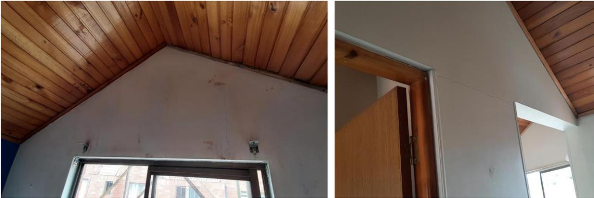
*Imágenes 10 y 11. Fisuras entre vigas de cubierta y cuchillas en algunas casas.*
