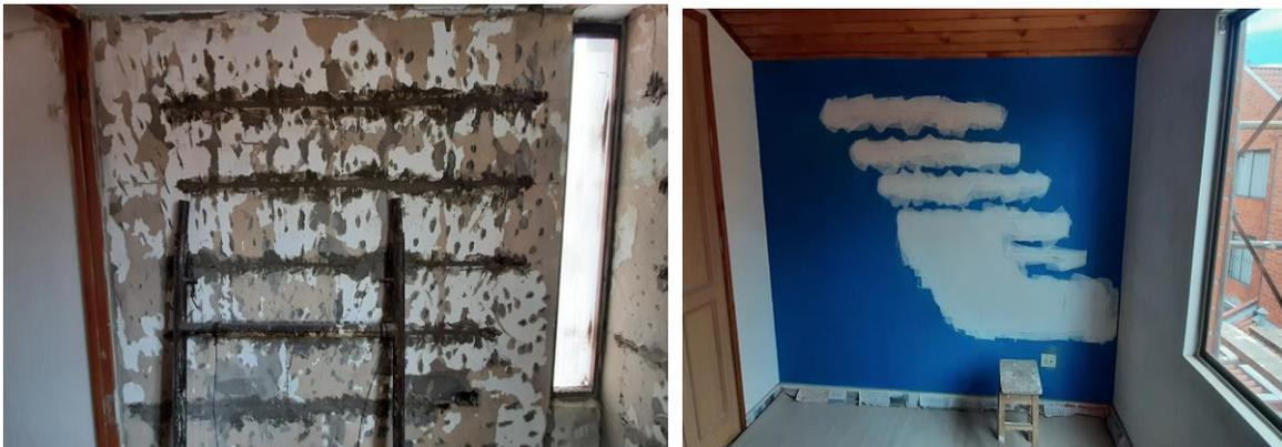
*Imágenes 8 y 9. Rehabilitación de muros mediante el uso de grapas en algunas casas.*
