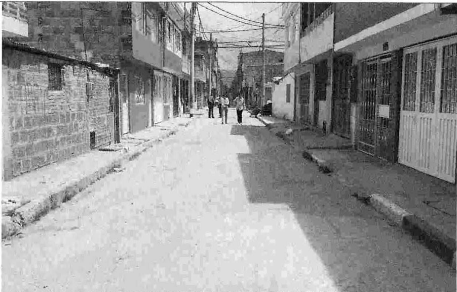
Fotografía 2. La vía no cuenta con pendiente de drenaje longitudinal en dirección al único sumidero presente en la calle, que pueda conducir eficientemente las aguas lluvias a dichas estructuras, por lo tanto el agua no drena y se infiltra en las capas de la estructura de pavimento produciendo ondulaciones y hundimientos presentes en el 65% de la totalidad de la calle
