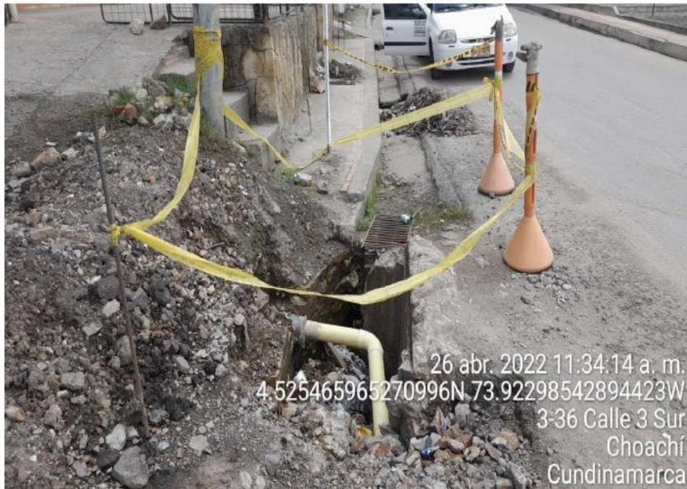
Al redireccionar las aguas al nuevo alcantarillado, se tiene como resultado que no se da ms rebosamiento de las aguas negras.
