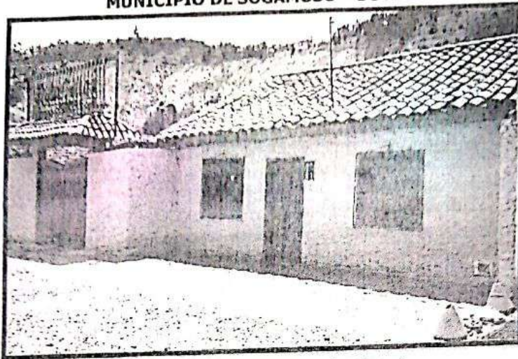
Foto-imagen Fachada Construcción Existente
