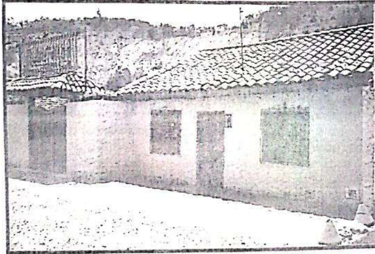
Foto-imagen Fachada Construcción Existente
