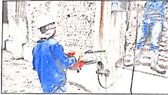
Img. Extracción de núcleo en el nivel +1.50, columna A'3.
