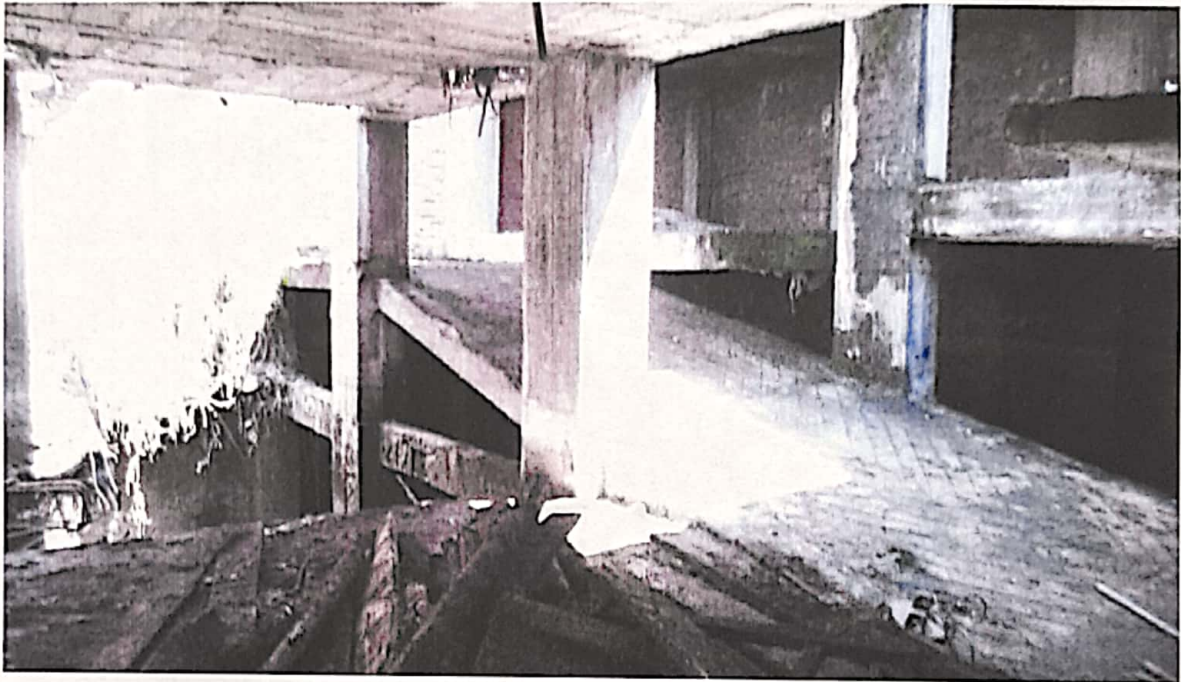
Fotografía 3. Rampa de acceso al semisótano y sótano de las obras existentes.
