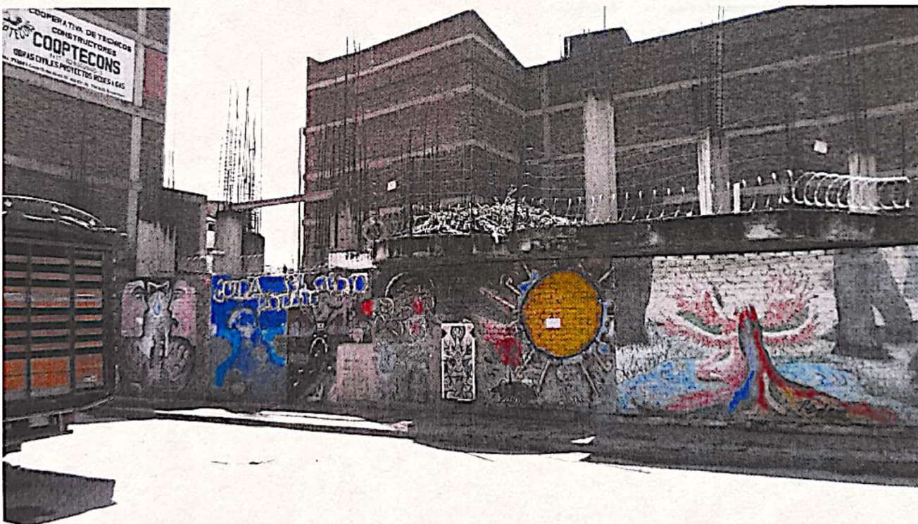
Fotografía 2. Obras existentes en el sitio del proyecto visto desde la calle 15.
