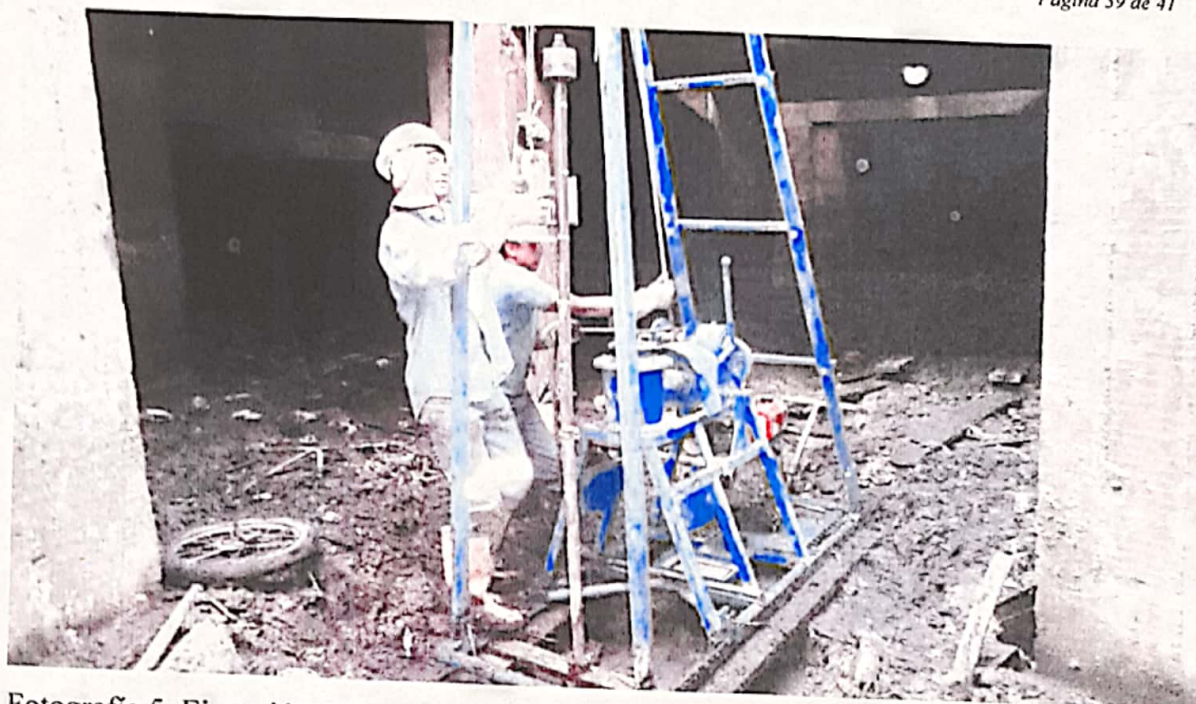
Fotografía 5. Ejecución del sondeo 1 para toma de muestras y pruebas de resistencia in situ.
