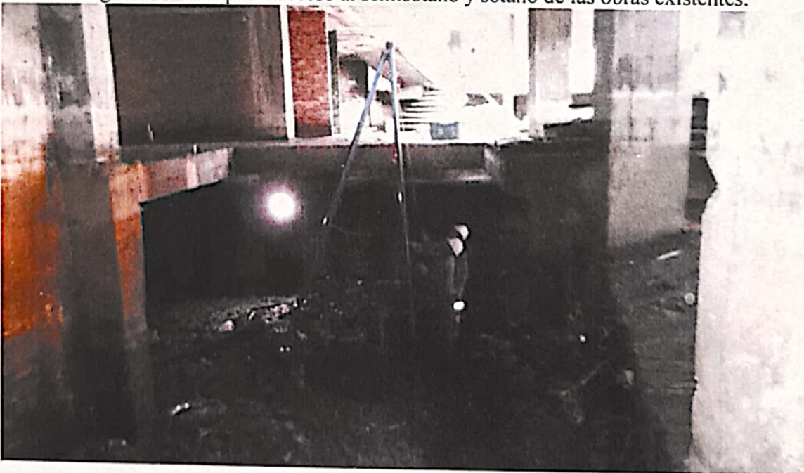
Fotografía 4. Altura del semisótano y sótano existente.
