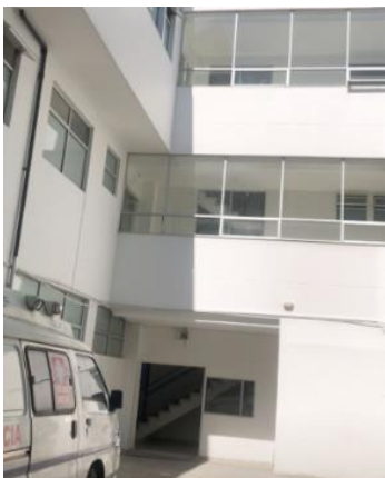
ZONA DE PARQUEO
