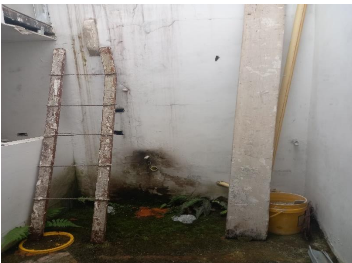
Patio de la vivienda sin la modificación
