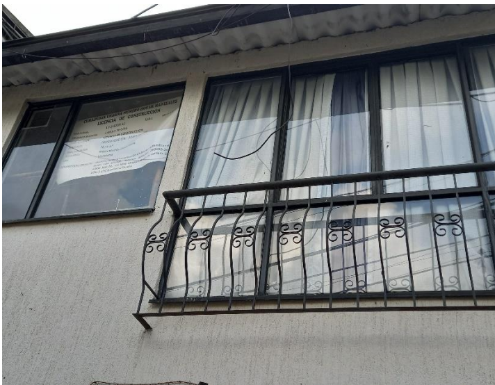
Fachada de la vivienda
