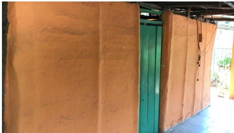
4. Habitación en mampostería, área 12m<sup>2</sup>. Habitación construida en bloque de arcilla, piso de concreto, puerta en teja de zinc y cubierta en teja de zinc.
