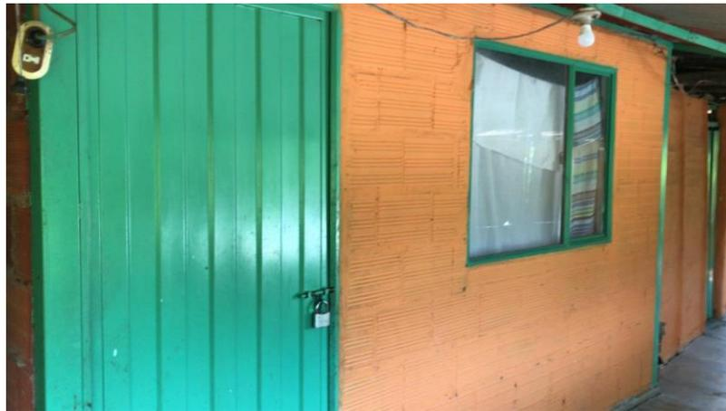
3. Habitación en Bahareque, área 14m<sup>2</sup>. Muros construidos en bahareque, pintura sobre muro y puerta de madera, pisos en concreto y cubierta de zinc.
