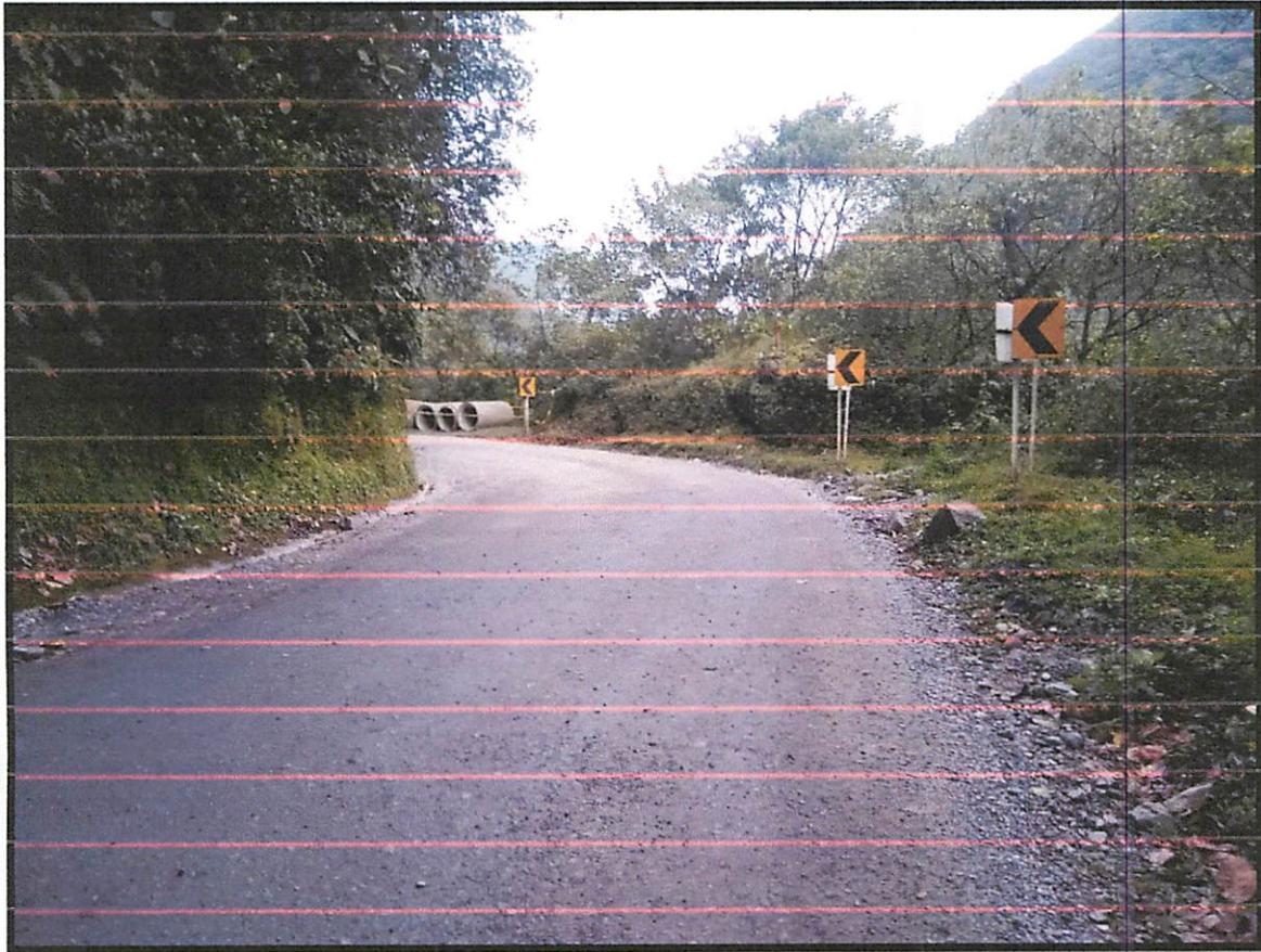
**FOTOGRAFIA 01** - Panorámica: Se observa el kilómetro 39 + 950 metros de la vía Guateque – Santa María, (Sentido Santa María – Guateque), donde se evidencia que se trata de una calzada en material afirmado (destapado) con dos carriles, en doble sentido de circulación, se observa señal vertical de chevron (Curva). Hay ausencia de demarcación horizontal y longitudinal.
