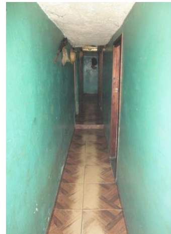
ACCESO VIVIENDA EN RESTAURANTE
