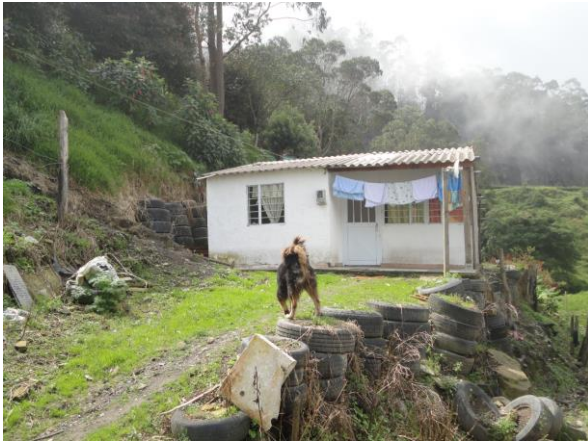
CASA PREFABRICADA EN LOTE 2
