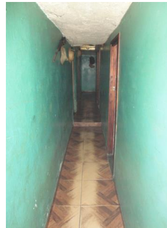
ACCESO VIVIENDA EN RESTAURANTE
