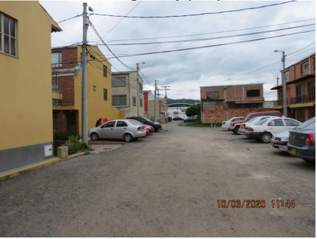
Zona común de ingreso y parqueaderos.
