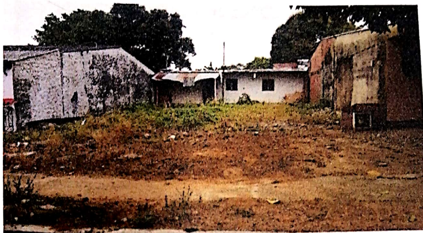
VISTA DE FACHADA Y CONTRUCCION
