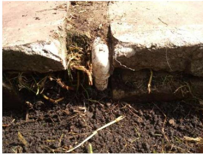
Foto 78 (2023) tubería lavaplatos reparada.
