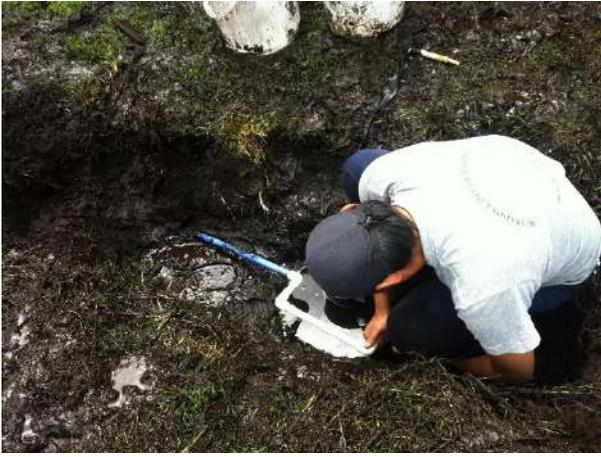
Foto 42 (2014) Reparación de tubería que trae el agua del acueducto al predio.
