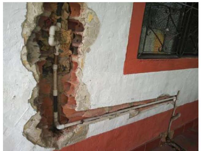
En el año 2014, daño en la tubería de la ducha del baño de la casa principal, se debió romper la pared hacer la reparación e instalar un nuevo enchape.
