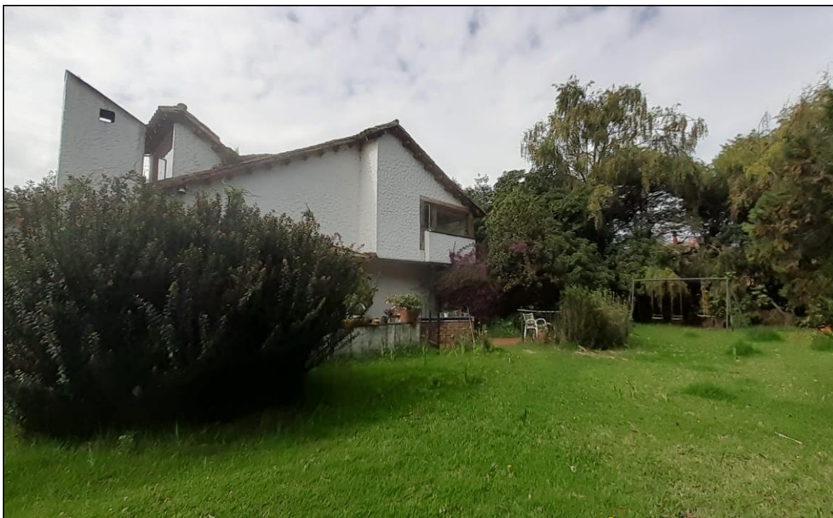
FOTO No. 06: Vista panorámica de la fachada posterior de la construcción campestre (2008), existente al interior del predio LOTE No. 06, en su estado actual. Se observan los retiros laterales contra predios colindantes.
