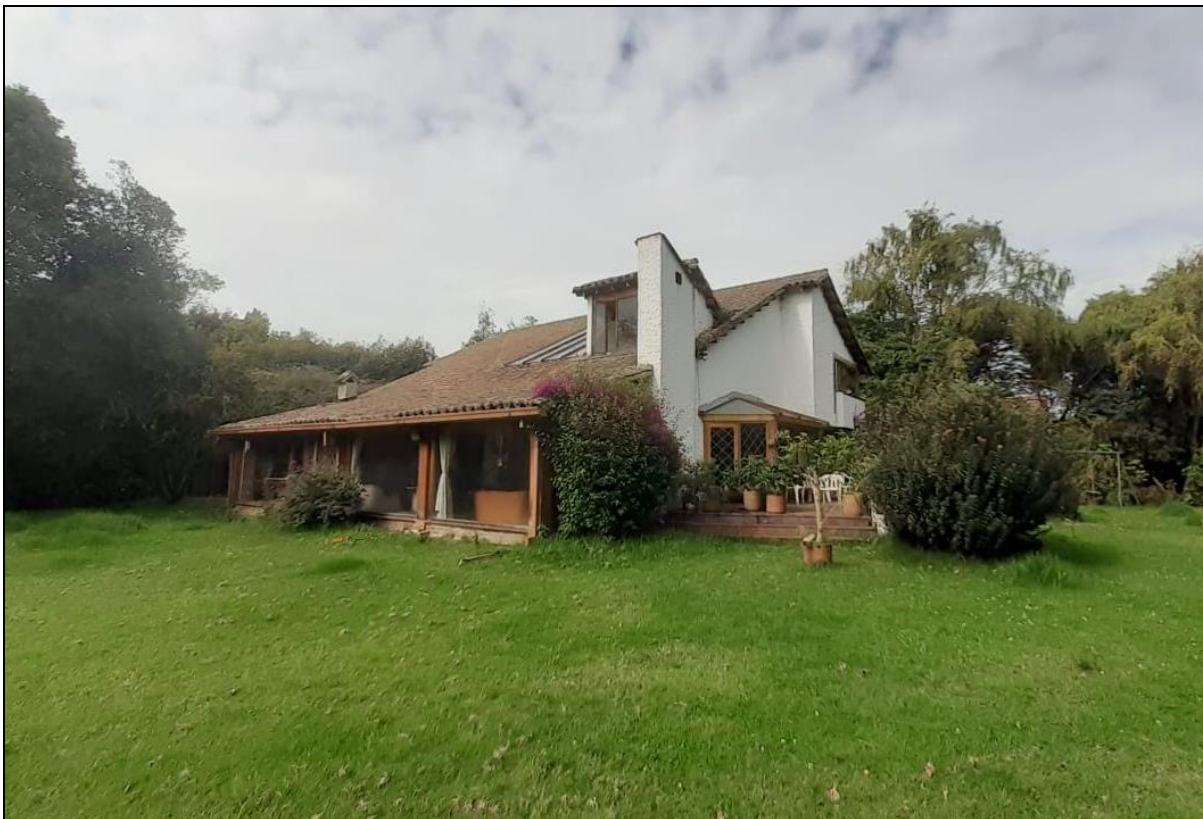
FOTO No. 05: Vista panorámica de la fachada de la construcción campestre (2008), existente al interior del predio LOTE No. 03, en su estado actual.
