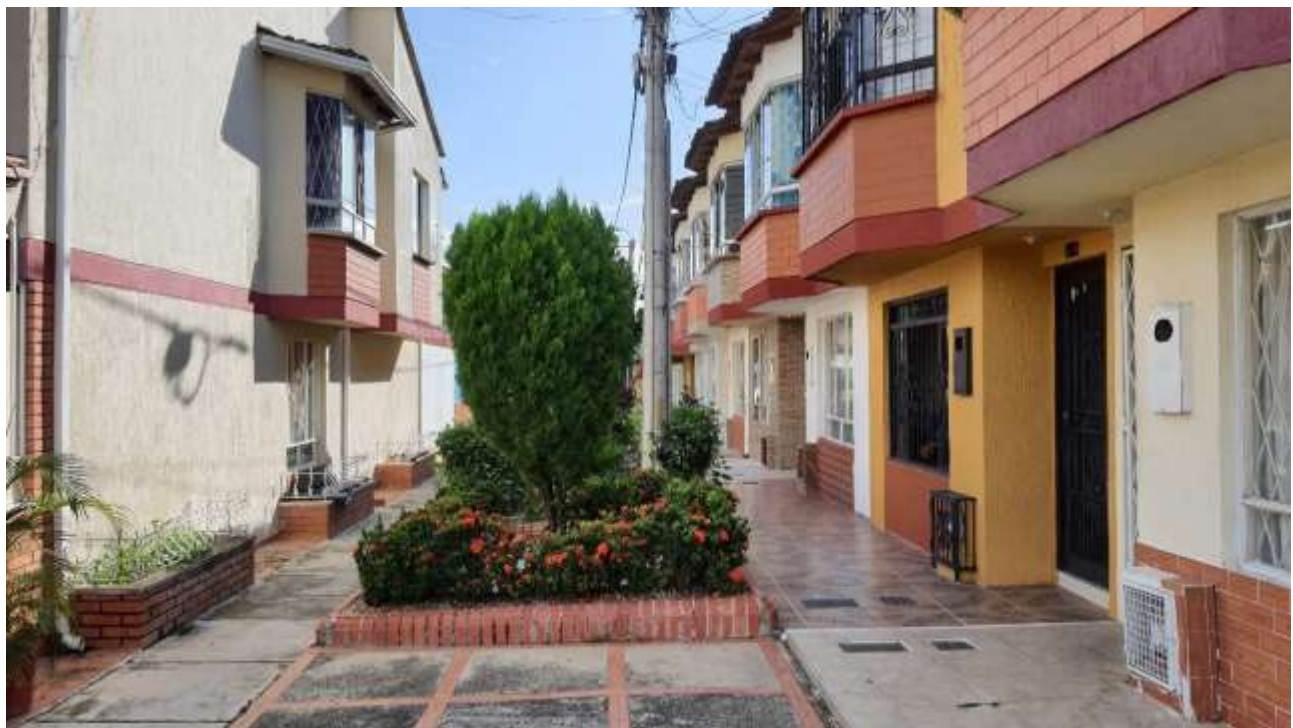
Vía peatonal sobre la cual se ubica el inmueble.
