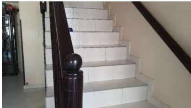
Acceso segundo piso
