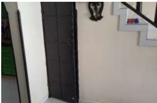
Acceso baño 1er piso
