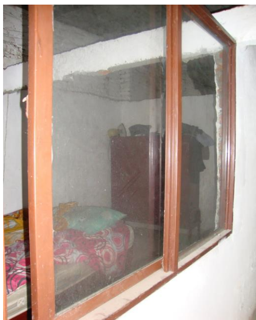
VISTA DETALLE ACABADO VENTANA METÁLICA
