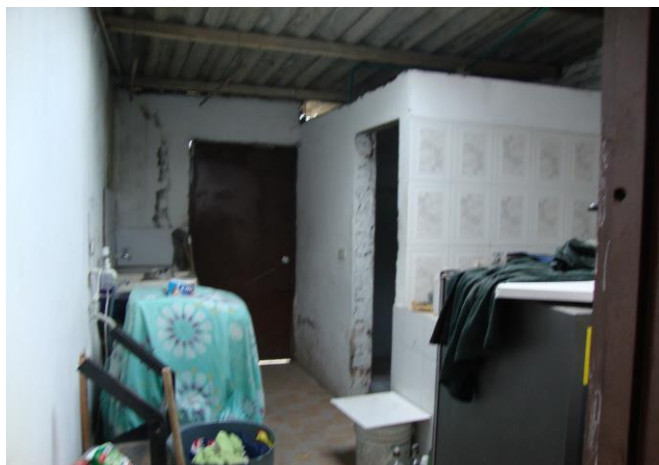
VISTA PARTE POSTERIOR SERVICIOS, VER ACABADOS
