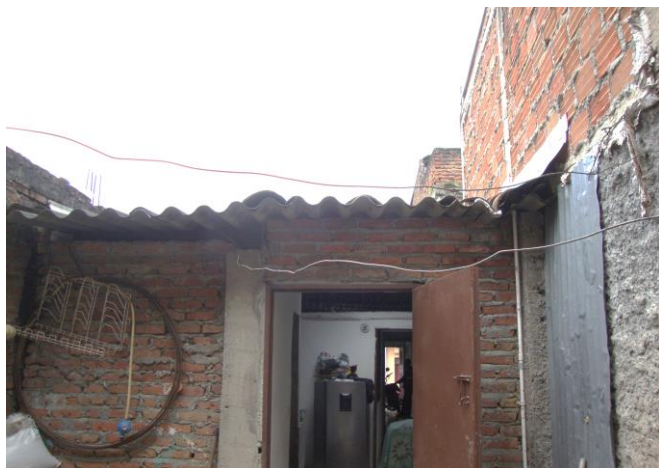
VISTA FACHADA POSTERIOR DE PATIO Y SUS ACABADOS
