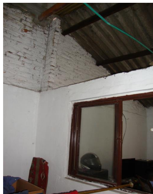
VISTA DETALLES VARIOS - MUROS Y CIELO
