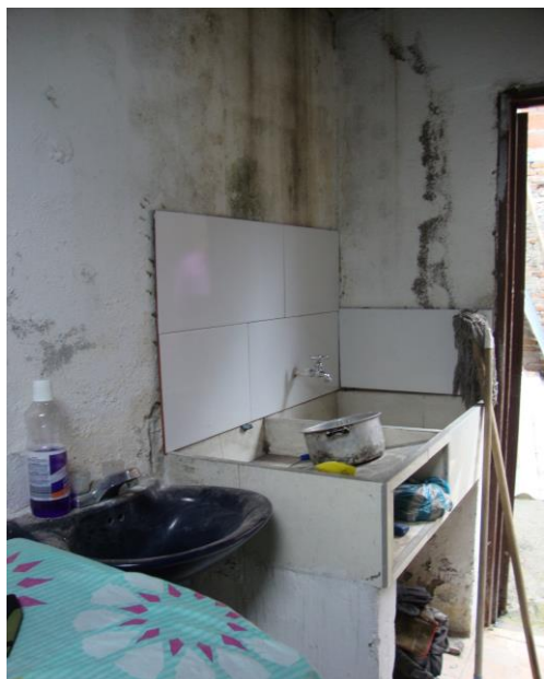
VISTA ZONA ROPAS, VÉANSE SUS ACABADOS
