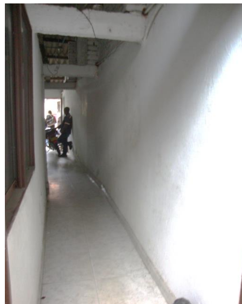
VISTA CORREDOR HACIA ACCESO, VER ACABADOS
