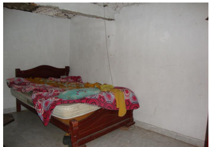
VISTA ALCOBA No.2, VER ACABADOS
