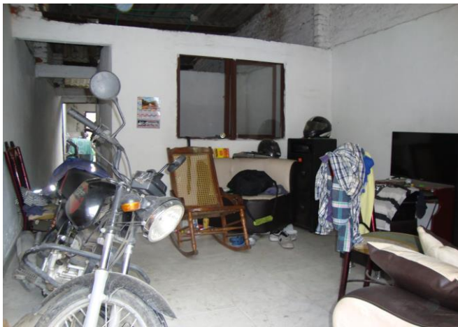
VISTA ÁREA SOCIAL DE ACCESO, VER ACABADOS
