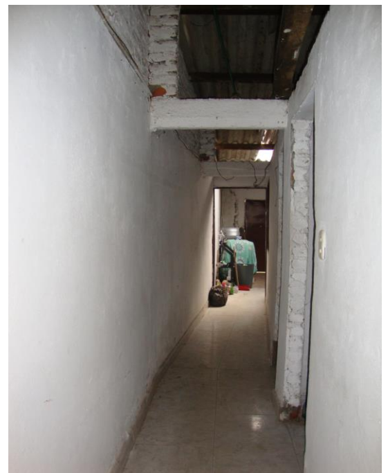
VISTA CORREDOR ACCESO A PARTE POSTERIOR
