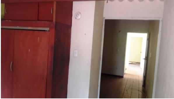
VISTA DE ESTADO DE CLOSET EN MADERA
