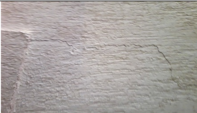
GRIETAS POSIBLEMENTE DE ASENTAMIENTOS SEGUNDO NIVEL
