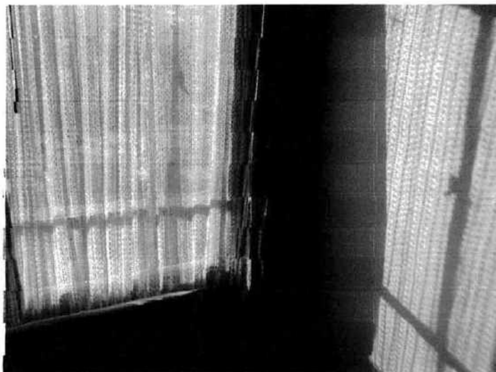
VENTANA SALA COMEDOR-FACHADA
