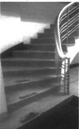
07 Punto fijo Edificio
