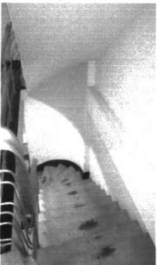
04 Punto fijo Edificio
