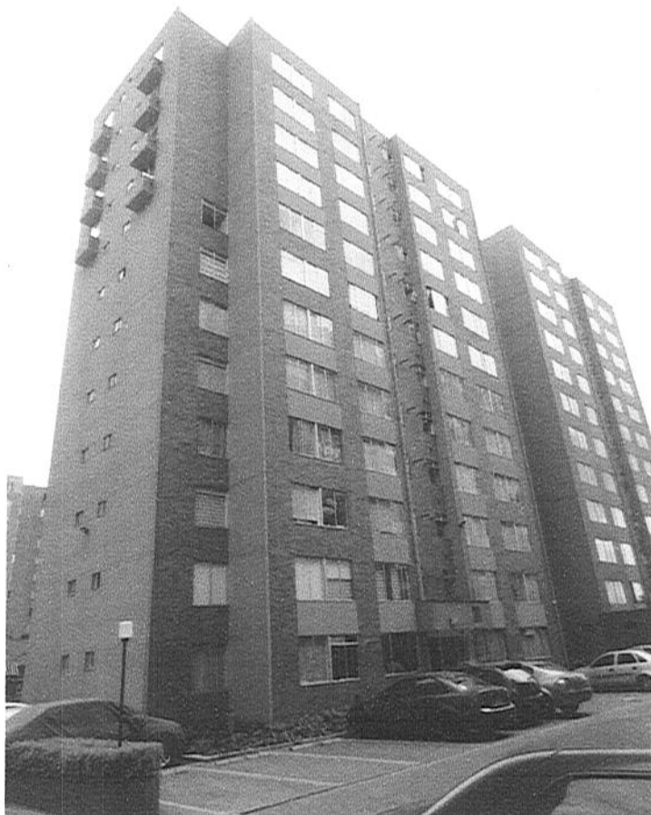
FACHADA TORRE 7 APTO 1104
