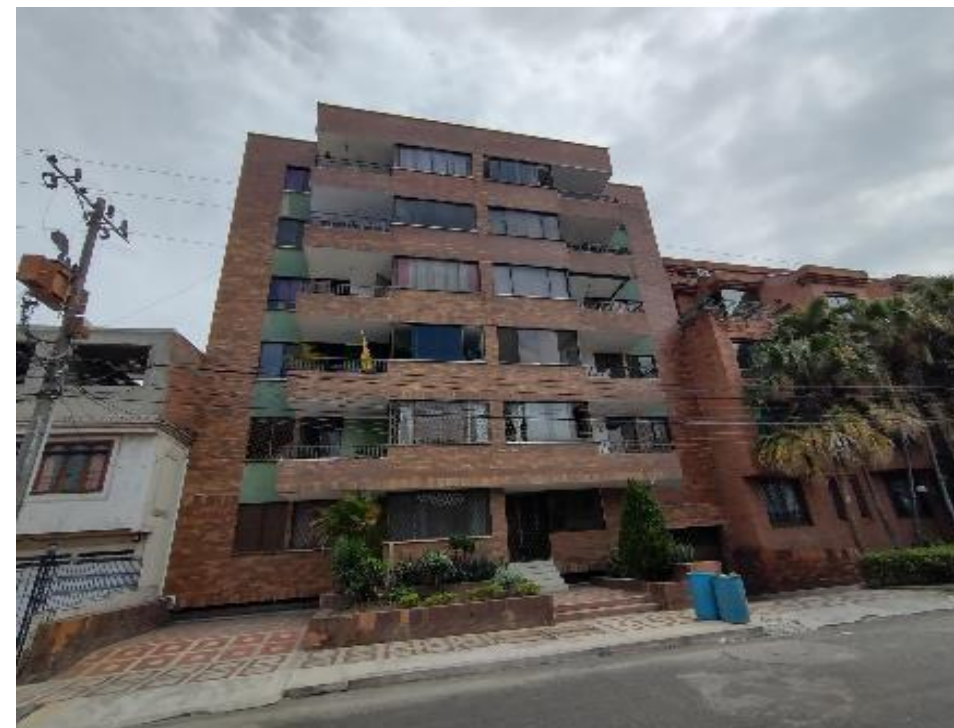
FACHADA 2 SOBRE CARRERA 83 A
