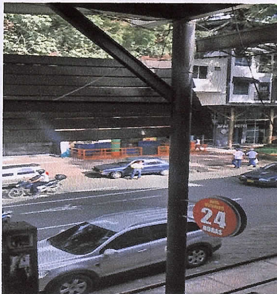
ESTRUCTURA PISO 3 Y 4
