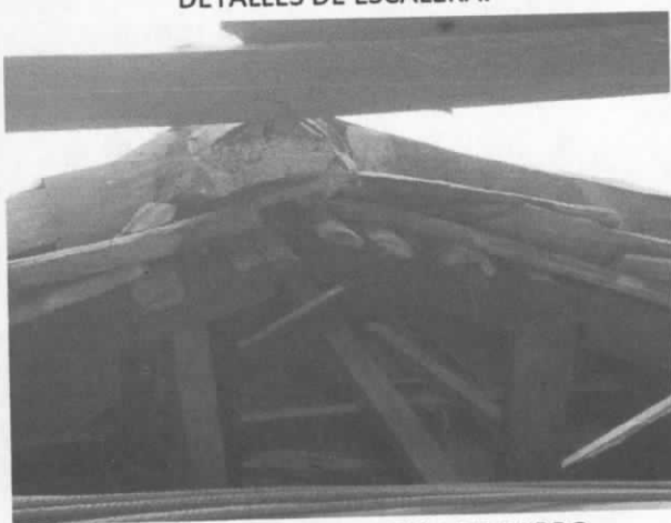
DETALLE CUBIERTA EN TEJA DE BARRO.
