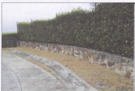
CERRAMIENTO MURO PERIMETRAL
