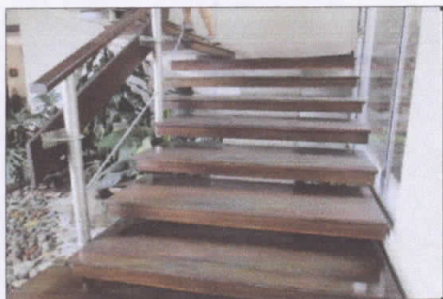
ACCESO INTERNO PISO 02
