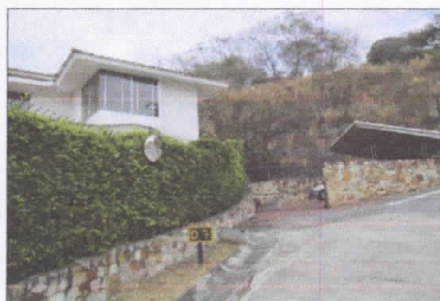
CERRAMIENTO MURO PERIMETRAL
