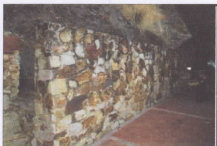
MUROS DE CONTENCIÓN
