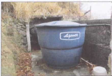
TANQUE DE RESERVA DE AGUA
