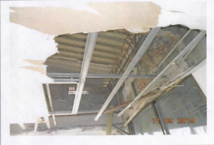
Techo y cielo falso
