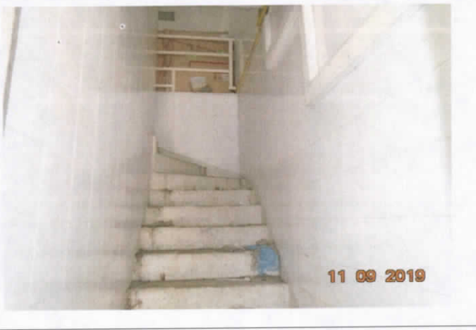
Escaleras de acceso segundo piso
