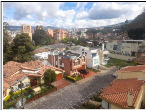
VISTA DEL SECTOR 1
