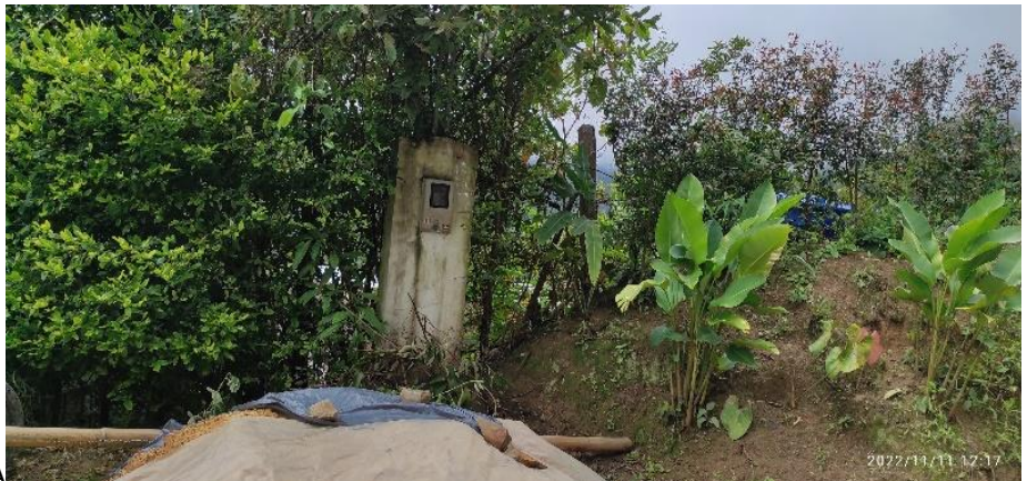
ACOMETIDA DE ENERGIA
