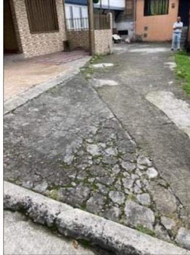
Durante la visita técnica no se observa ningún tipo de excavación en el terreno colindante al punto de la demanda. Se observa que la zona mencionada en la demanda está en un nivel superior y al parecer se está desbarrancando en el borde de la parte lateral de la misma.
