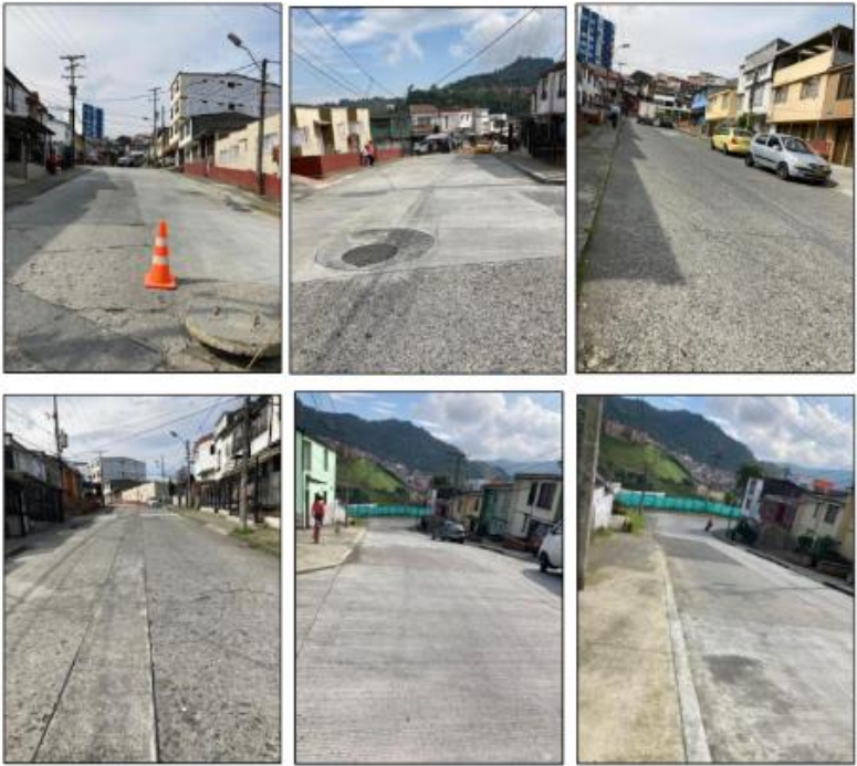
Pavimento en general en buen estado y losas con reposición reciente
