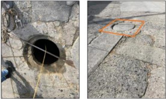
Encerrado en polígono color naranja, recuadro a reponer por parte de la Empresa Aguas de Manizales S.A. E.S.P. mediante Orden de Trabajo N° 2022,OT,12690
