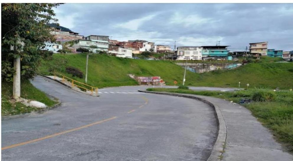
Imagen que muestra la carencia de señalización tanto vertical como de piso demarcando la proximidad a paso peatonal.
