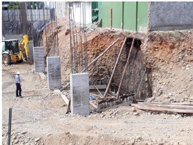
El muro verde es de nuestro predio, detrás de este se encuentra el muro vecino. En la fotografía se observa las vigas de cimentación, el armado de la zarpa y el muro de contención. La
