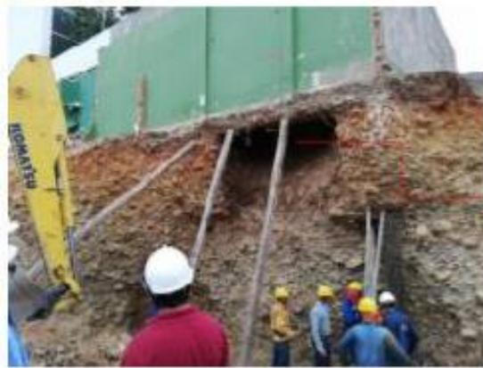
Socavación generada por el proceso de excavación, humedad y características del terreno ya que en ese punto queda el patio de la Vivienda vecina. Se evidencia cambio del tipo, características y consolidación del suelo.
