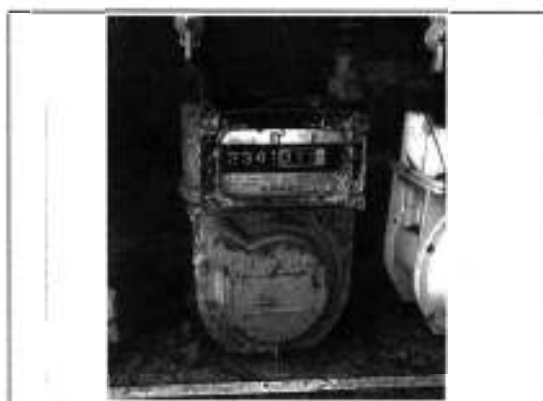
Medidor de gas natural
