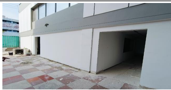
Imagen 4. PENDIENTE INSTALACION DE PUERTAS
