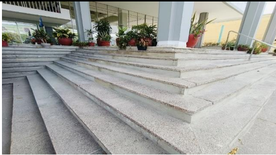
Imagen 1. RESANE EN MORTERO DE REPARACION PARA ESCALERAS
