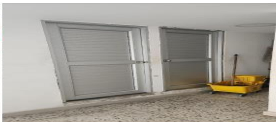
Instalación de puertas metálicas
