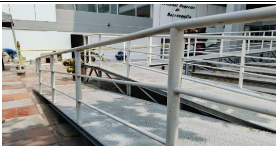
Imagen 3. MANTENIMIENTO DE BARANDAS
