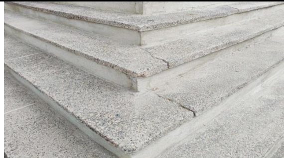
Imagen 2. RESANE EN MORTERO DE REPARACION PARA ESCALERAS
