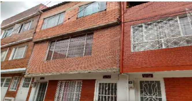
Fachada del Inmueble
