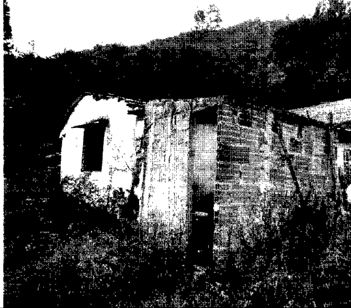
Foto No. 7 Detalle de mejora construida.
