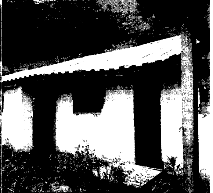
Foto No. 2 Detalle al interior.
