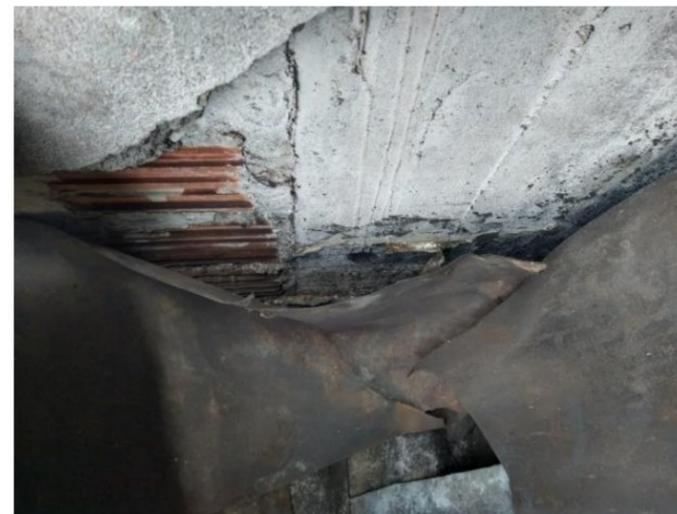
Infiltración por revoque desprendido y quemado
