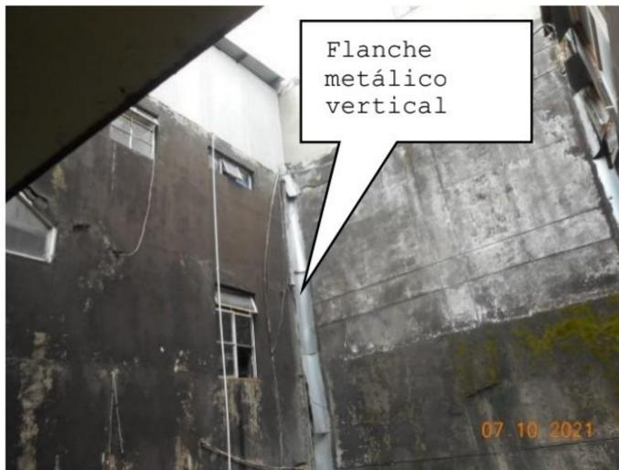
Infiltración por remate metálico vertical
