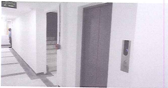
ASCENSOR Y ESCALERAS
