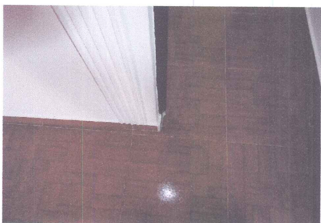
ACABADOS DE PISO
