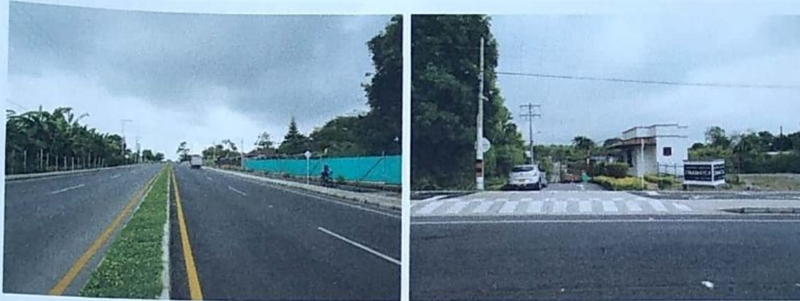
Detalle Entorno y Portería
