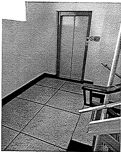
ASCENSOR Y ESCALERA
