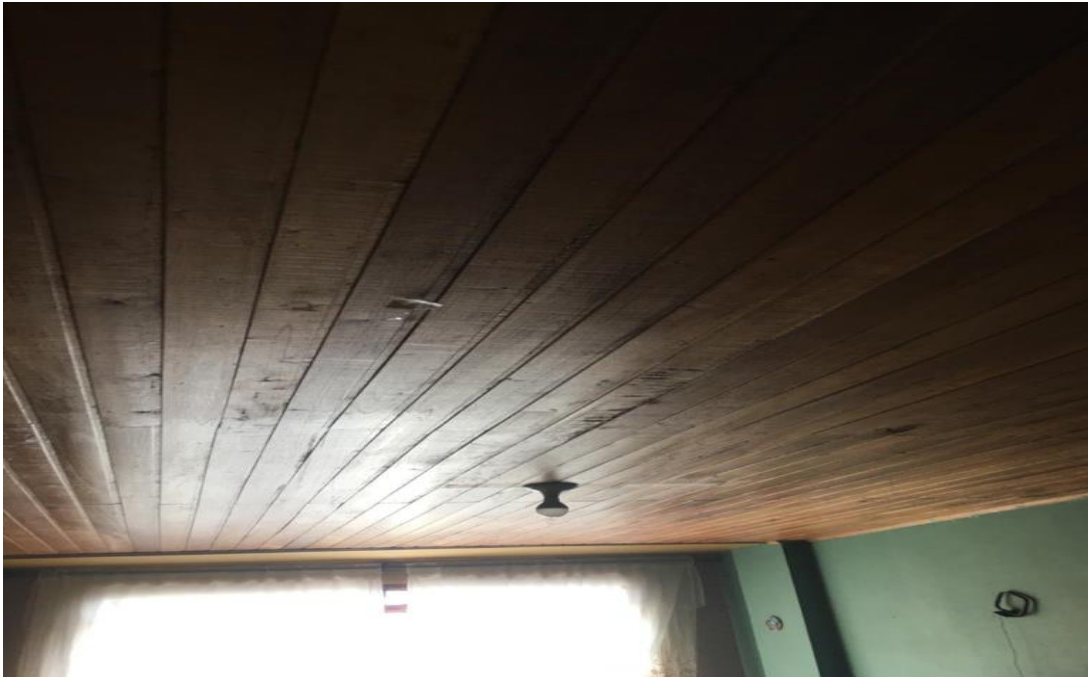
CIELO RASO VIVIENDA 2
